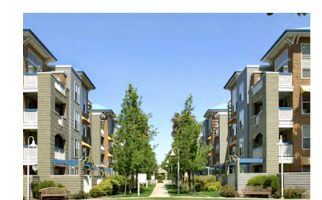
Rincon de los Esteros 82 Family Affordable Units
