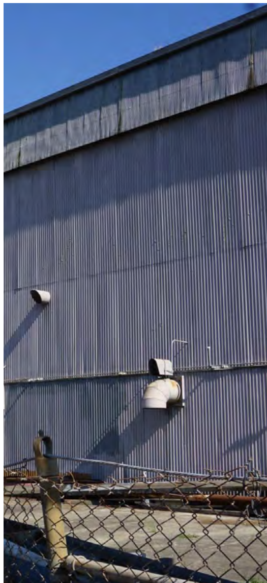
FIGURE 41. Antiguo edificio de acero en el sitio
