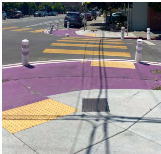
EXTENSIONES DE BORDILLOS Y CRUCES PEATONALES DE ALTA VISIBILIDAD
