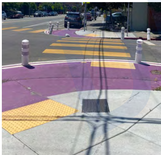
MỞ RỘNG LỀ ĐƯỜNG LỐI BĂNG QUA ĐƯỜNG DỄ THẤY
