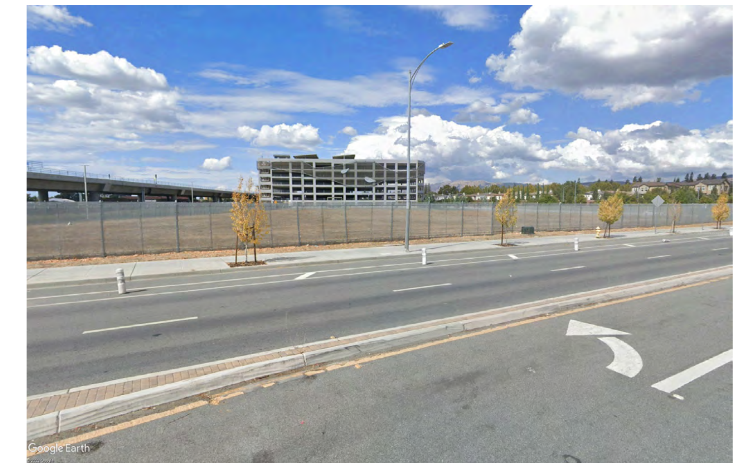
VIEW FROM SOUTH VER DESDE EL SUR 從南面看 NHÌN TỪ PHÍA NAM
