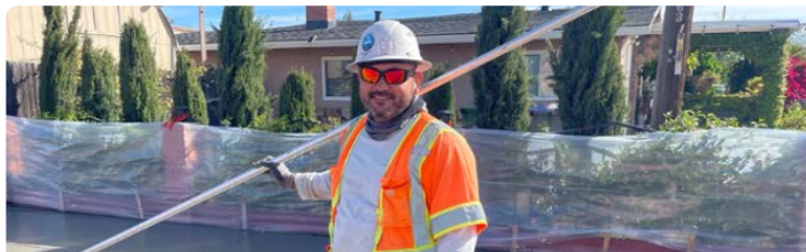
Trabajadores especializados en cemento, otros en obras generales, y otros en jardinería son algunos de los trabajadores que construyen la ampliación del tren ligero en East San Jose, que transforma y mejora el transporte en la comunidad [Foto de VTA/EBRC/LFP].
