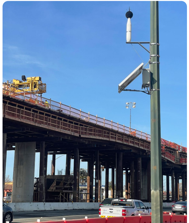
Los monitores de ruido y vibración instalados a lo largo de la zona de construcción permiten al equipo de EBRC garantizar que el proyecto cumpla con las normas de la Administración Federal de Aviación (FAA). (Foto de Lupita Franco Peimbert).
