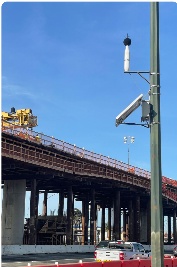
Thiết bị giám sát tiếng ồn và mức rung được lắp đặt dọc khu vực xây dựng, cho phép nhóm EBRC bảo đảm dự án tuân thủ các quy định của Cục Hàng Không Liên Bang. (Hình ảnh của Lupita Franco Peimbert).
