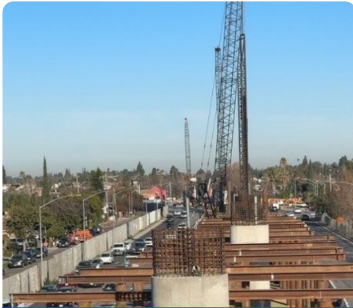
Cimbras de acero (Falsework) en el camellón de Capitol Expressway, al norte de Story Road. (Foto de Mohammad Alazzah).
