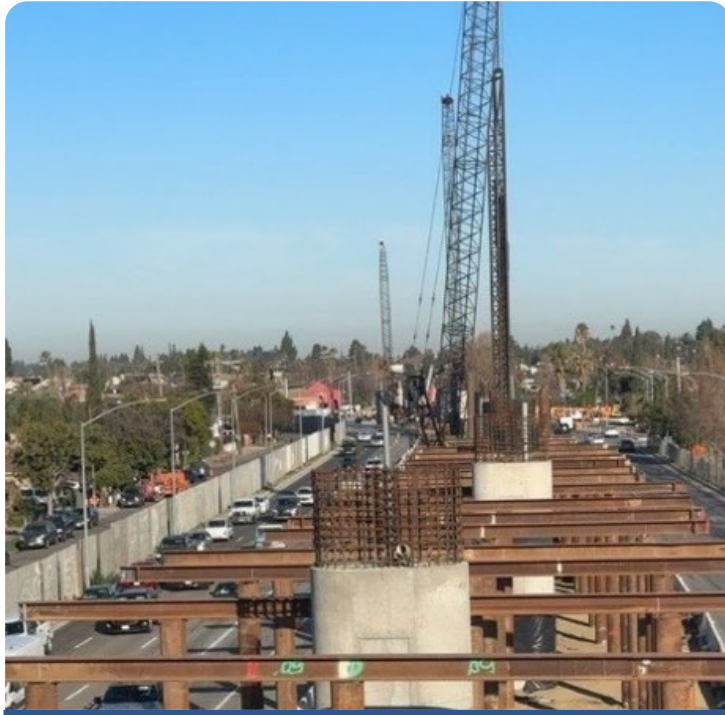
Nagtatayo ng bakal na falsework sa gitna ng Capitol Expressway, hilaga ng Story Road. (Larawan ni Mohammad Alazzah).
