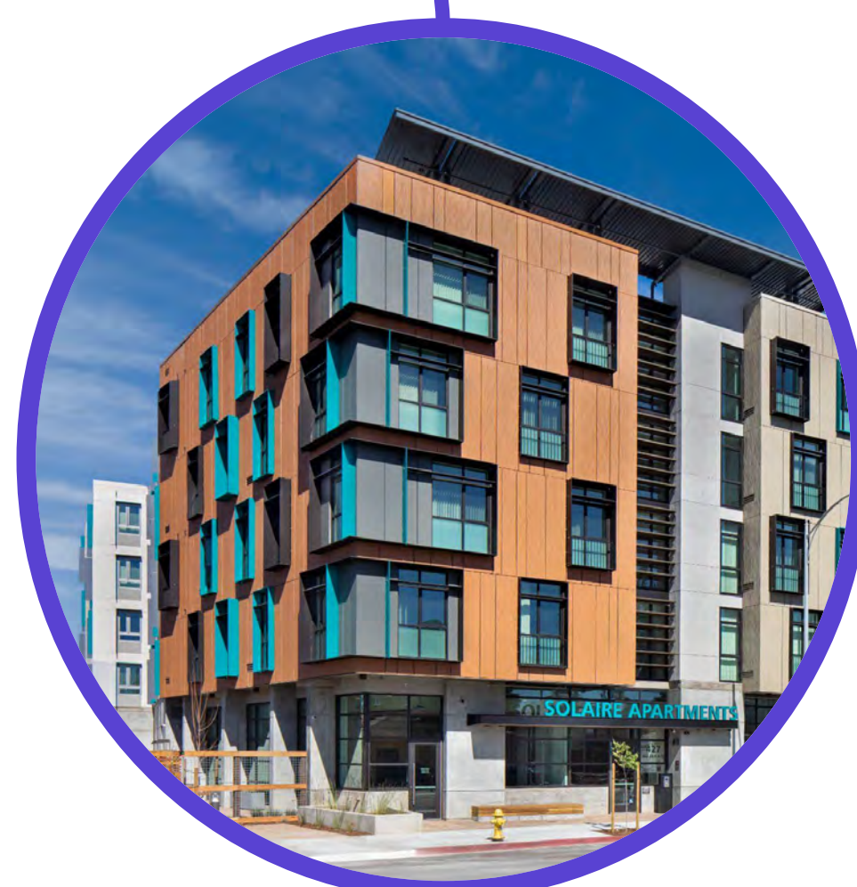
Main Entry Corners Anchor Building 主入口轉角的主體建築
