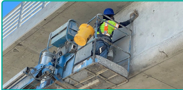
Un albañil retoca en seco pequeñas imperfecciones en la superficie del puente. (Foto de Lupita Franco Peimbert)
