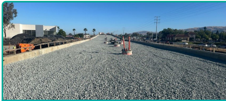
Giàn thép tạm và cốp pha nâng đỡ kiến trúc thượng tầng và sẽ được tháo dỡ khi cầu hoàn tất. Ở bên trái là cây cầu đang được xây dựng; ở bên phải là giàn thép tạm và cốp pha. Photo by Mohammad Alazzah.
